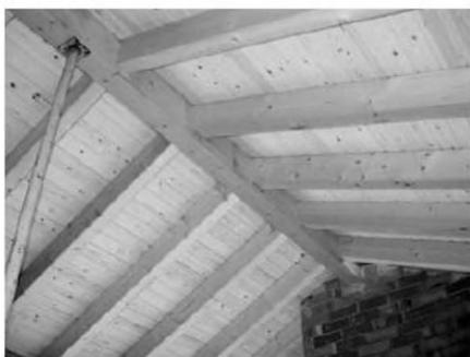
Correas que apoyan sobre una viga de cumbrera mediante un ensamble de cola de Milano Redondeada. La unión queda oculta y el resultado es muy limpio. Normalmente se deben disponer tirafondos oblicuos entre correa y viga como refuerzo en caso de incendio.
